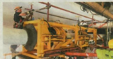
Bei der Trinkwasserleitungs-Sanierung an einer Brücke kam das DynTec-Verfahren zum Einsatz.
