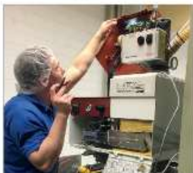
Bei jeder Wartung wird die Leimauftragungstechnik auf Optimierungspotenziale geprüft.
