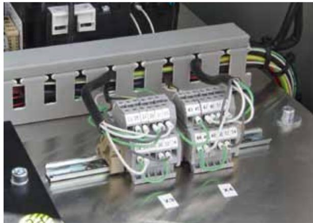
Anschlussklemmen für die Pumpensteuerung
