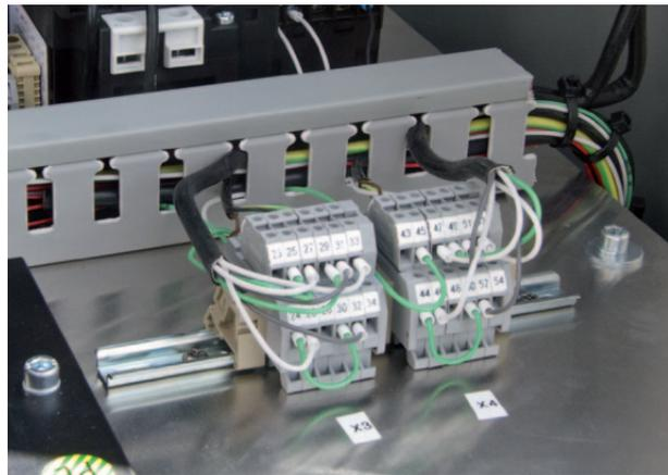
Anschlussklemmen für die Pumpensteuerung
